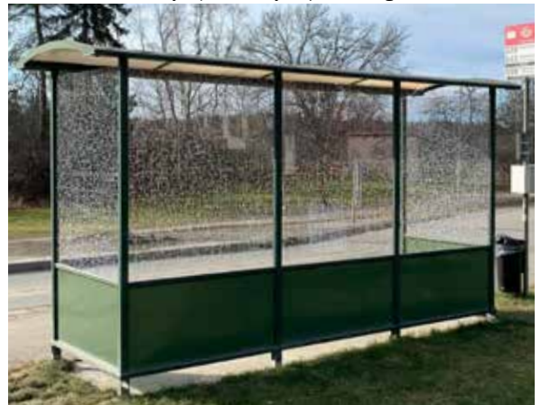
Busskur med förtryckt repmönster
