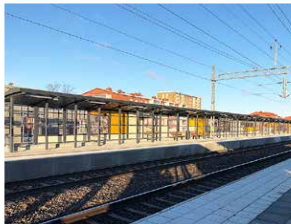
Kombinert værbeskyttelse/støydemping på Rosengårds stasjon
