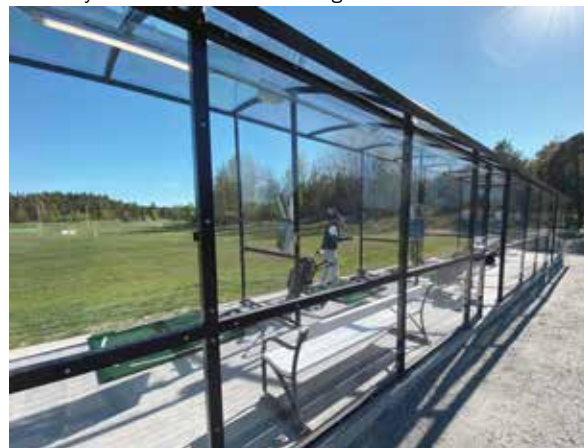
Hammerglass-skuret som værbeskyttelse på driving range
